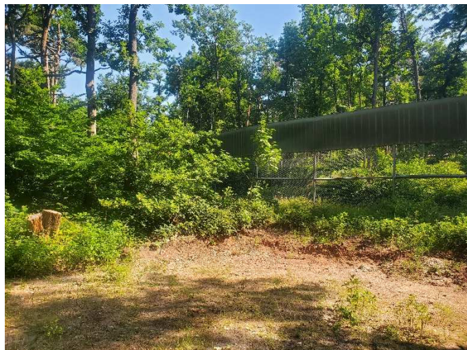
Terrassements récents effectués pour la mise en place de réserves d'eau
